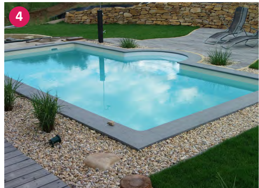
▲ Fertiges Styroporsteinbecken mit Römertreppe
