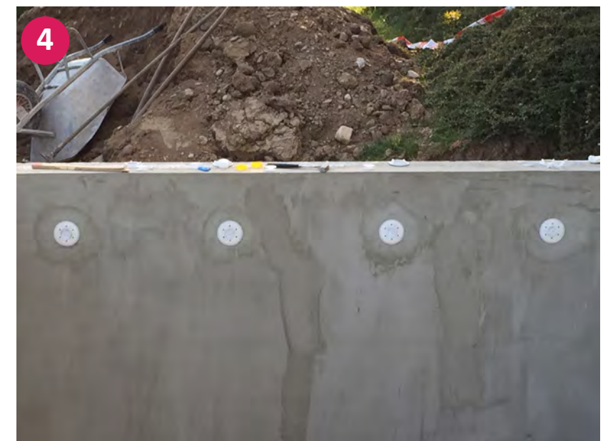
▲ Wichtig: Abdrücken der Rohrleitungen!
