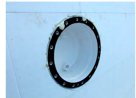
▲ Fertig eingeschäumter Scheinwerfer
