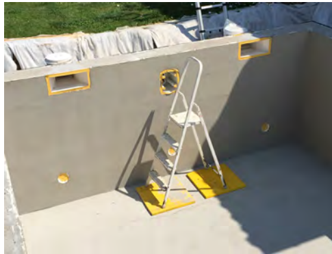
▲ Fertig verspachtelte Innenwand
