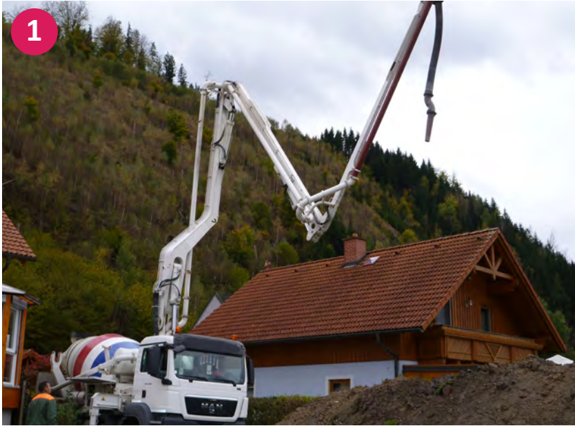
▲ Betonwagen mit Betonpumpe
