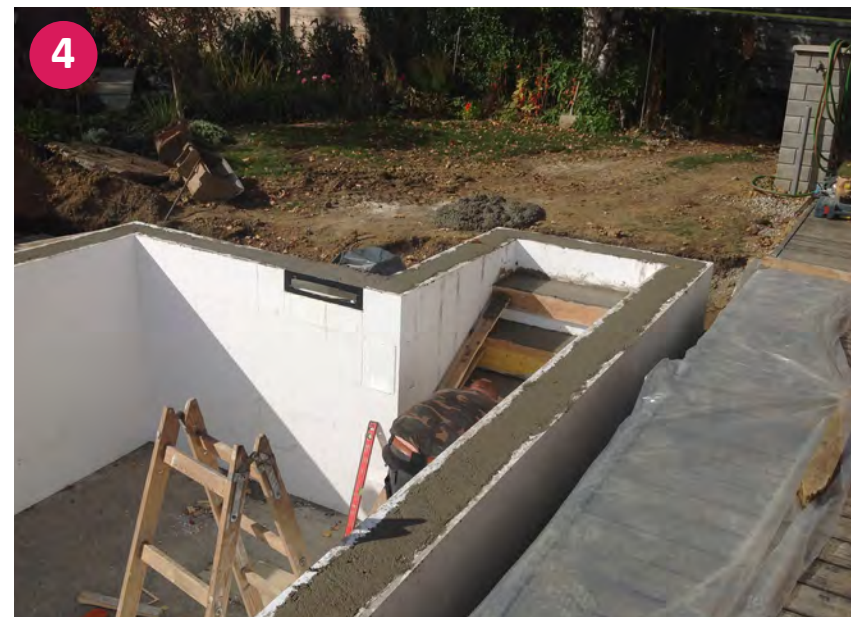
▲ Fertig ausgefülltes Styroporsteinbecken mit Beton
