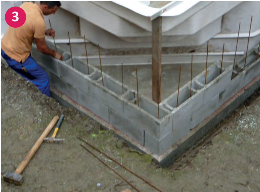
▲ Untermauerung der Ecktreppe
