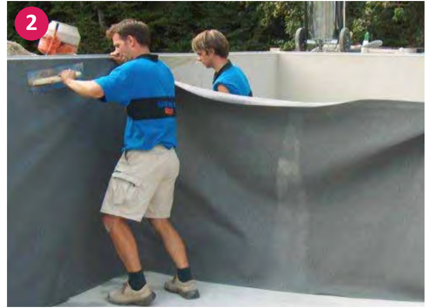
▲ Punktuelle Befestigung der Vliestrennlage mittels Styroporkleber
