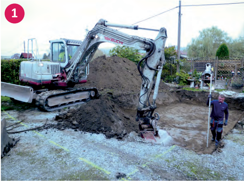
▲ Aushub der Baugrube
