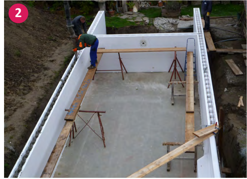
▲ Ausfüllen der Styroporstein mit dem Beton
