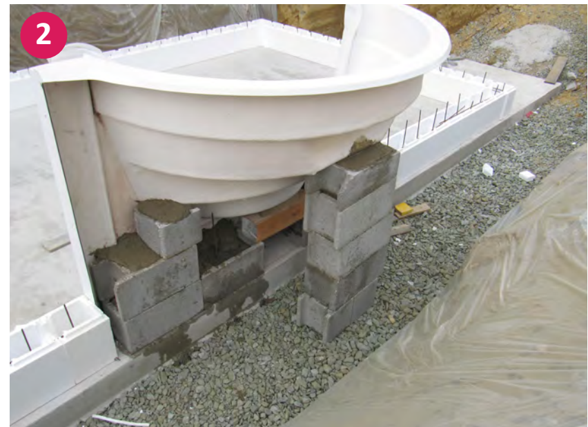
▲ Untermauerung der Römertreppe
