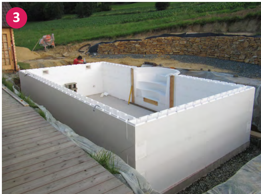
▲ Aufgestelltes Styroporstein Becken mit Römertreppe – ohne Betonfüllung
