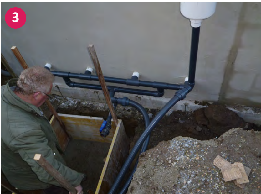
▲ Verrohrung von Düsen, Skimmer und Bodenablauf
