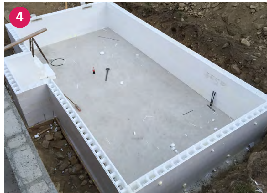
▲ Fertig aufgestelltes Styropor Becken – ohne Betonfüllung
