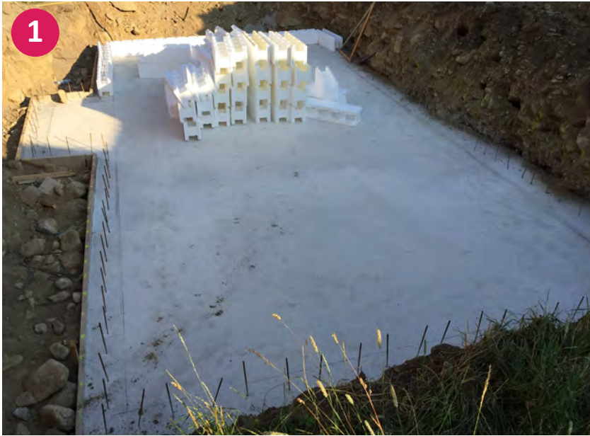
▲ Fertig ausgehärtete Bodenplatte
