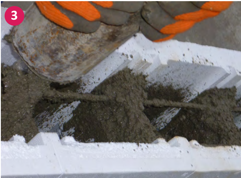
▲ Detailsicht: Ausfüllen der Styroporstein mit dem Beton
