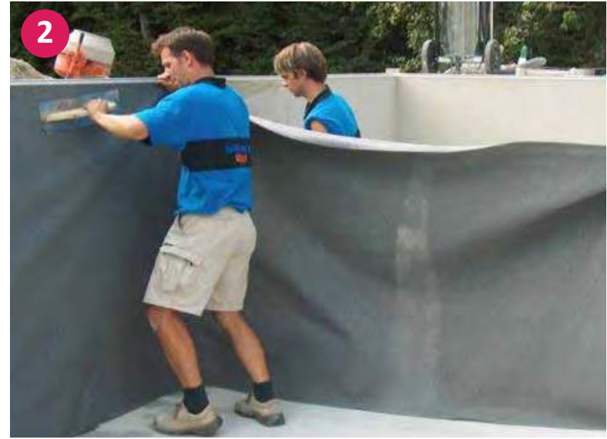
▲ Punktuelle Befestigung der Vliestrennlage mittels Styroporkleber
