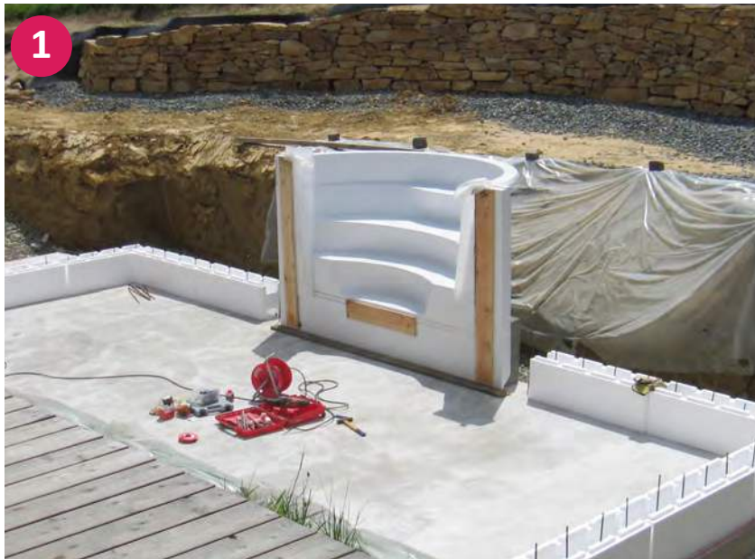
▲ Römertreppe mit erster Ansatzreihe Styroporsteine
