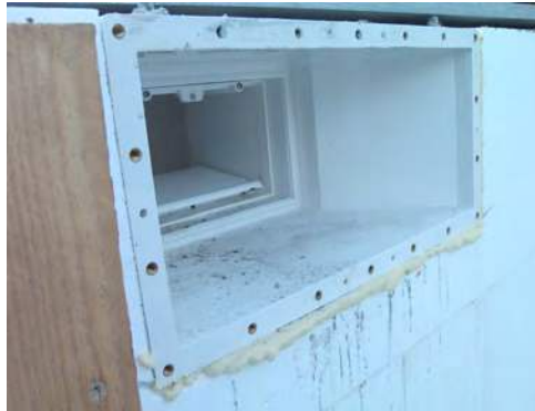
▲ Fertig eingeschäumte WH-Skimmer
