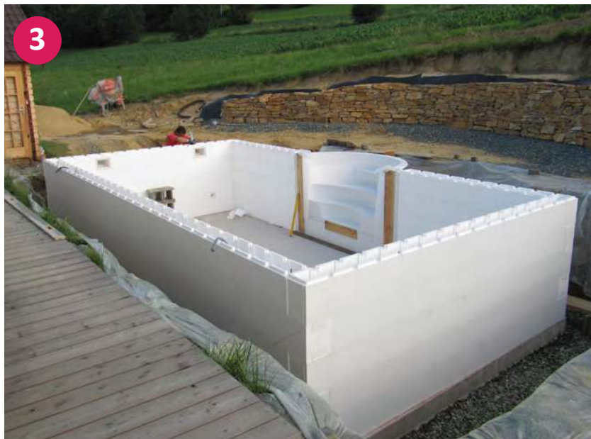
▲ Aufgestelltes Styroporstein Becken mit Römertreppe – ohne Betonfüllung
