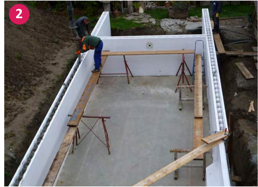
▲ Ausfüllen der Styroporstein mit dem Beton
