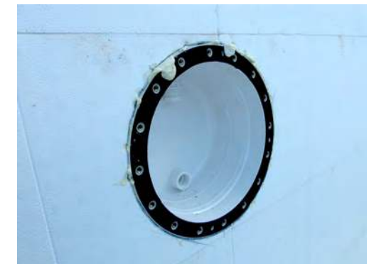
▲ Fertig eingeschäumter Scheinwerfer
