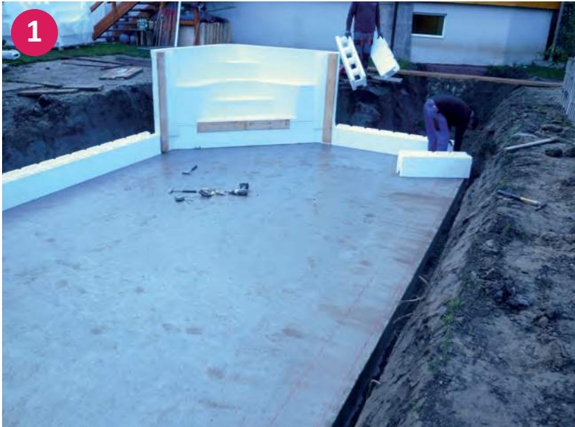
▲ Ecktreppe mit erster Ansatzreihe Styroporsteine
