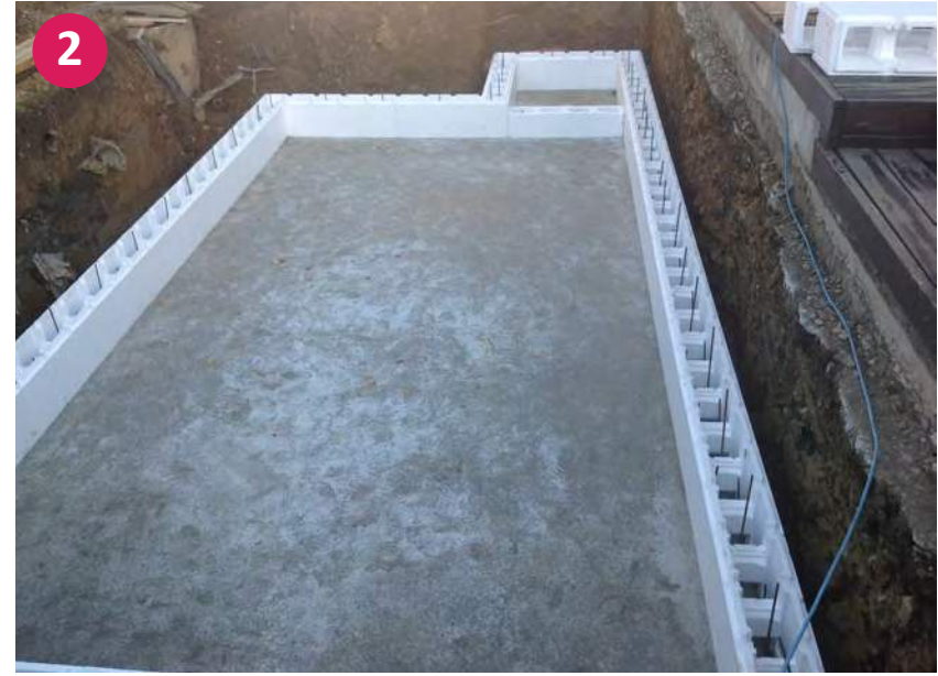
▲ Ansätzen der ersten Reihe Styropor Steine
