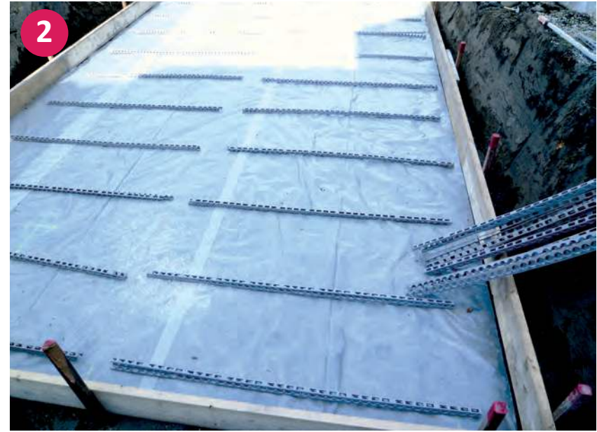
▲ Abschallung der Bodenplatte
