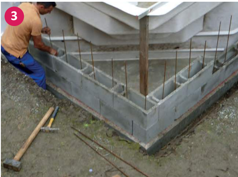
▲ Untermauerung der Ecktreppe
