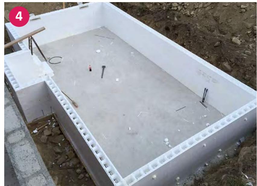
▲ Fertig aufgestelltes Styropor Becken – ohne Betonfüllung
