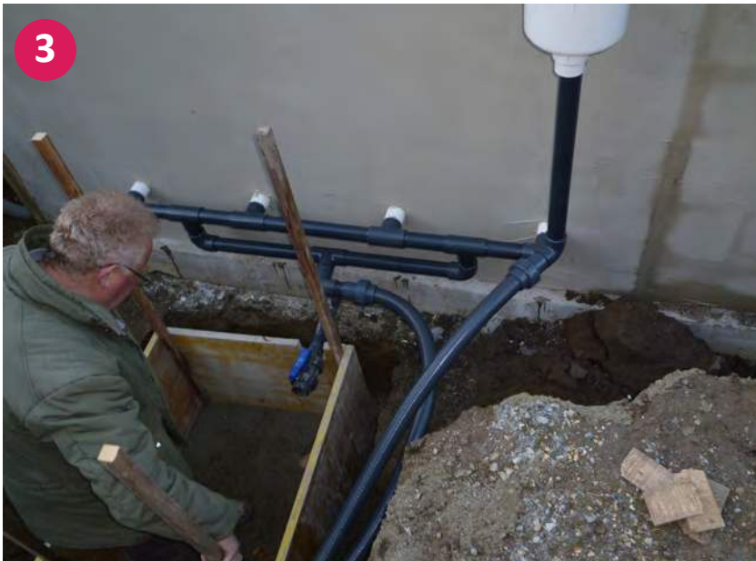
▲ Verrohrung von Düsen, Skimmer und Bodenablauf
