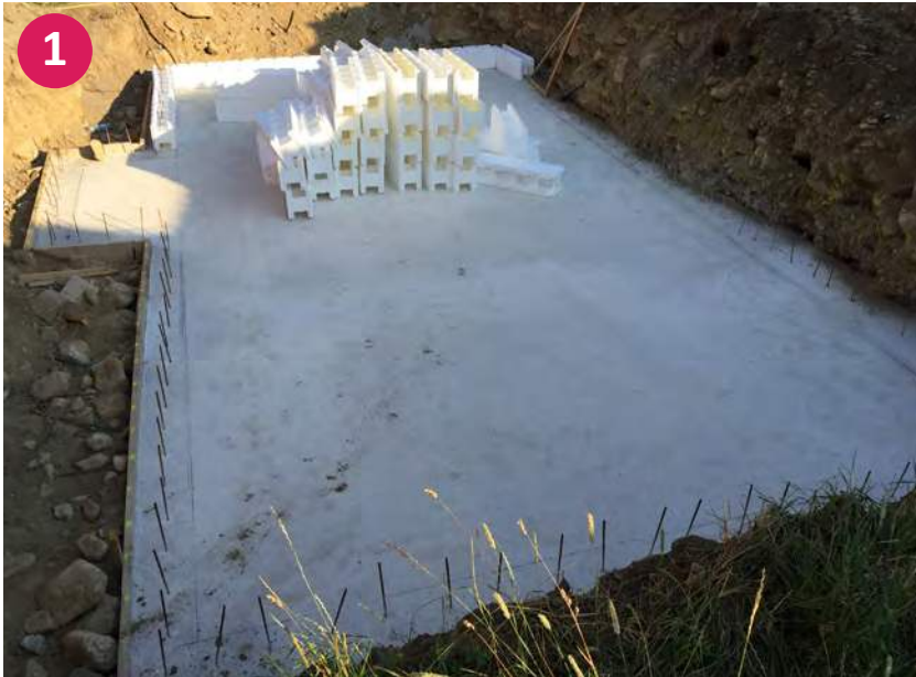
▲ Fertig ausgehärtete Bodenplatte
