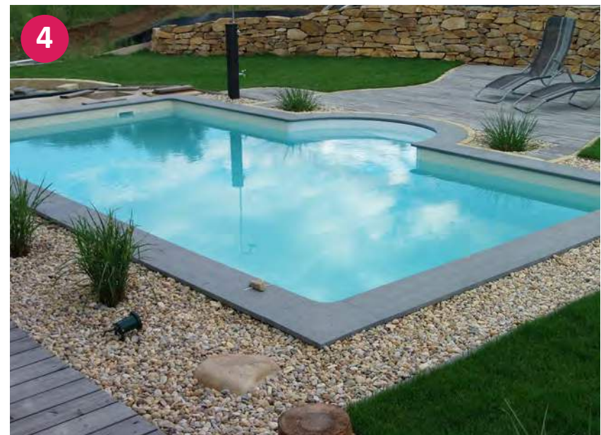
▲ Fertiges Styroporsteinbecken mit Römertreppe
