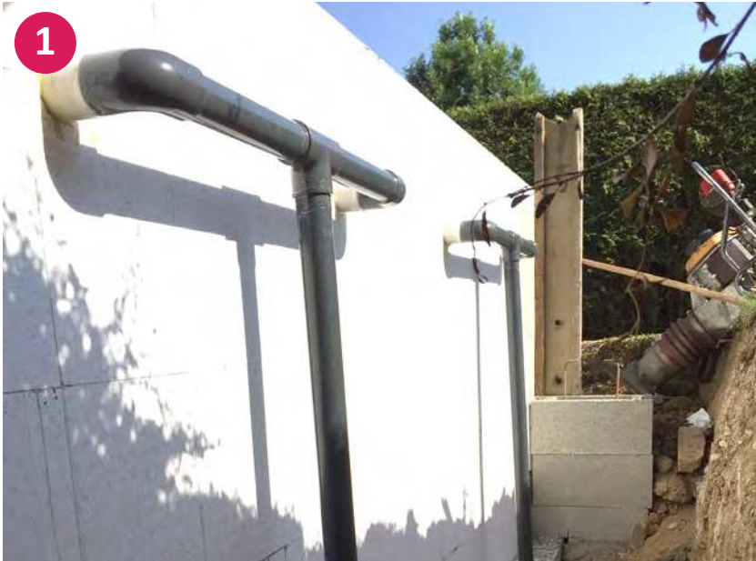
▲ Verrohrung von 4-Düsen
