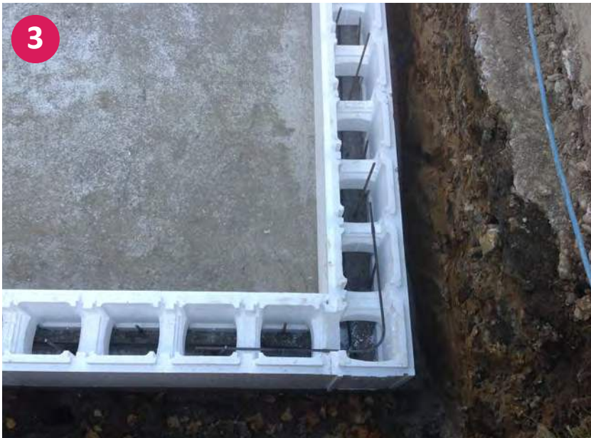
▲ Detailbild einer Eckverbindung samt Eisenarmierung
