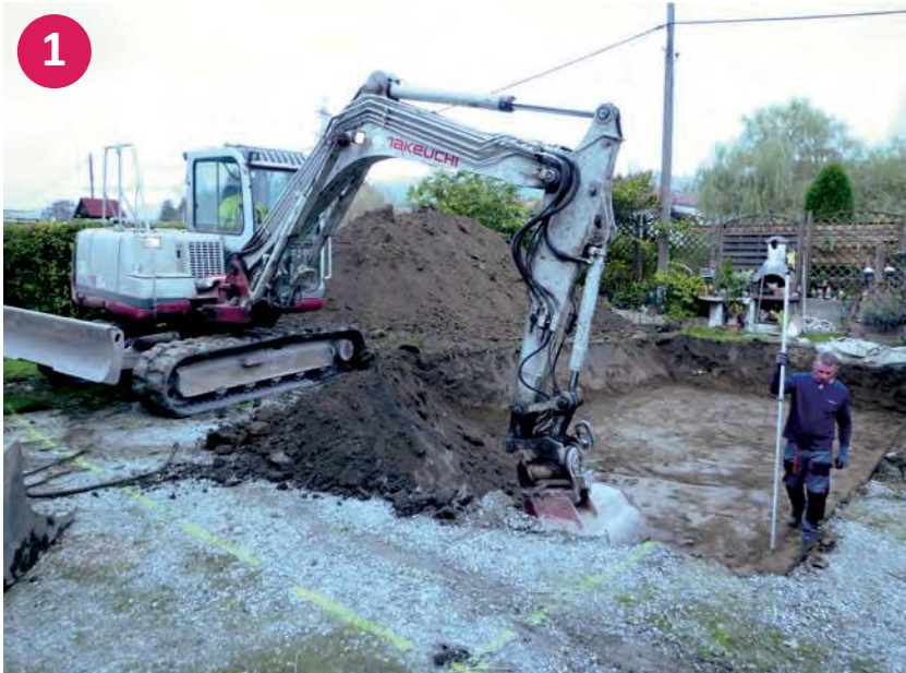
▲ Aushub der Baugrube
