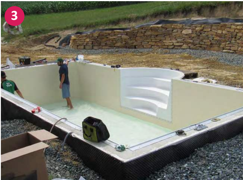
▲ Einhängen des Foliensacks und Anflanschen der Einbauteile
