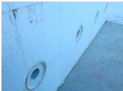
▲ Fertig eingeschäumte Wanddurchführung
