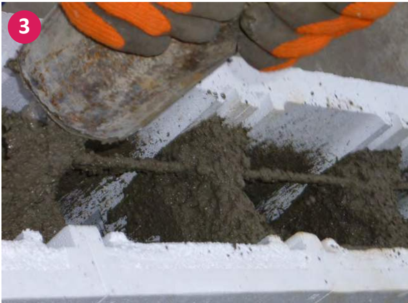
▲ Detailansicht: Ausfüllen der Styroporstein mit dem Beton
