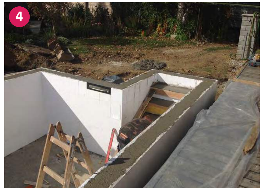
▲ Fertig ausgefülltes Styroporsteinbecken mit Beton
